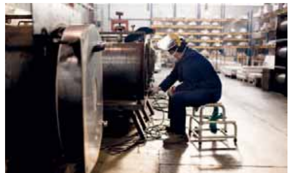
ICI Caldaie S.p.A., Zevio (VR)
